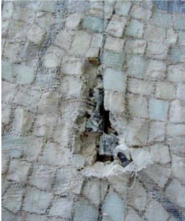
De petits trous ont été pratiqués pour donner accès et tronçonner les pattes de fixation. Les joints horizontaux ont ensuite été sciés au disque diamanté.
