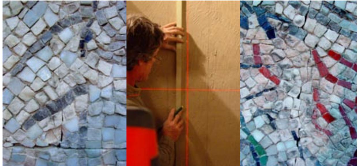
Pour retrouver la juste position des plaques au remontage un quadrillage de verticales et d'horizontales avait été tracé sur les plaques avant dépose (voir ci-dessous à gauche). Son relevé précis et son report au niveau laser sur les mur du nouveau bâtiment, a permis de restituer une jonction très précise comme en témoignent les images ci-dessus à gauche et à droite. Celle de gauche montre la différence qualitative finale entre le joint horizontal scié et le joint vertical éclaté.
