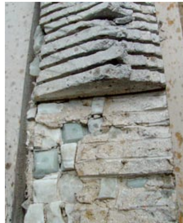
Maintenu sur la face par un complexe de tarlatane, de bois et de résine polyuréthane, la totalité du mortier de pose a pu être découpé en bandelettes et progressivement éliminé jusqu'à faire apparaître le revers des tesselles. La bande de mosaïque a ensuite été transposée sur une plaque de ciment-armé semblable aux autres.
