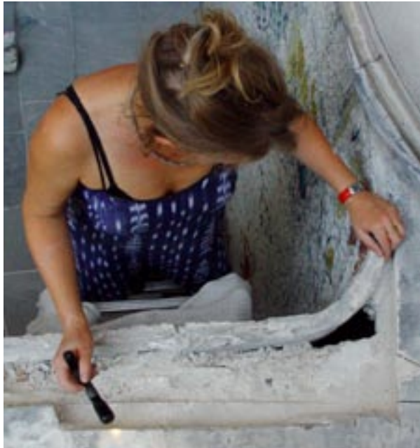
Les angles arrondis de la mosaïque avaient bien été réalisés en atelier sur des plaques de ciment-armé cintrées,
