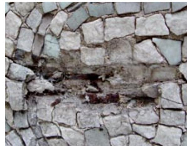
L'oxydation des armatures en fer faisait par endroit éclater le mortier de pose et provoquait la perte de tesselles
