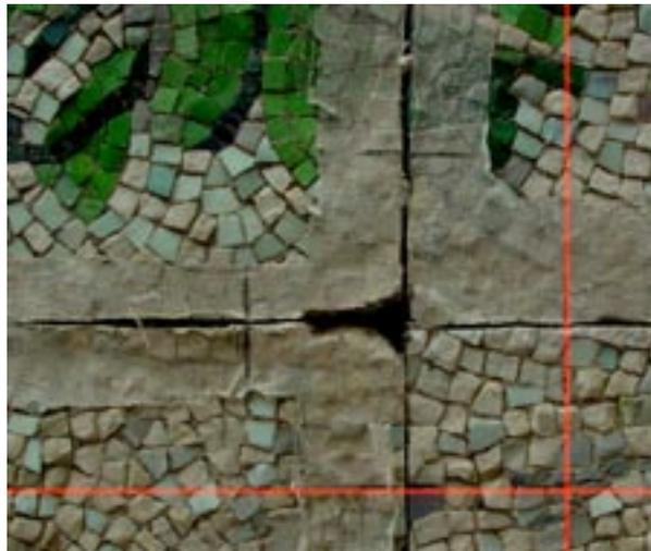
l'oxydation des fers d'armature, tout d'abord par la protection du toit en verre, ensuite par une large ventilation arrière qui empêcherait la stagnation d'humidité entre le mur et la mosaïque.
