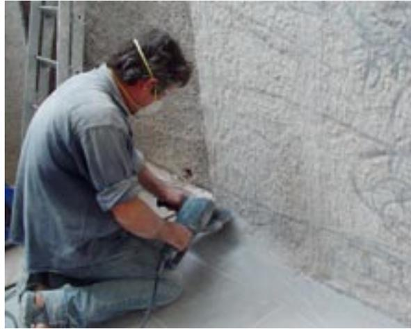
Cet ordonnancement des pattes métalliques (en laiton ou en fer) s'avéra relativement systématique ce qui permit dans la suite de la dépose d'effectuer des petits trous d'accès pour tronçonner la retenue avant la séparation des plaques. Toujours soucieux d'éviter une rupture diagonale des plaques, les deux joints horizontaux ont été sciés au disque diamanté. Par contre, il nous est vite apparu possible d'éviter
