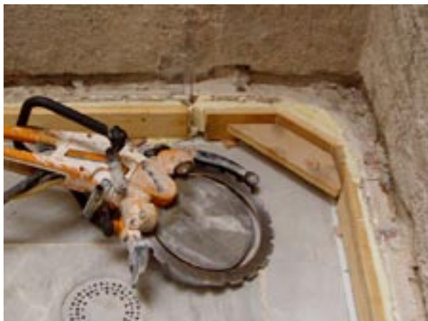
Une procédure particulière a été mise en œuvre pour sauver la bande de mosaïque réalisée sur place entre le sol et les plaques sur un comblement au mortier de ciment.
