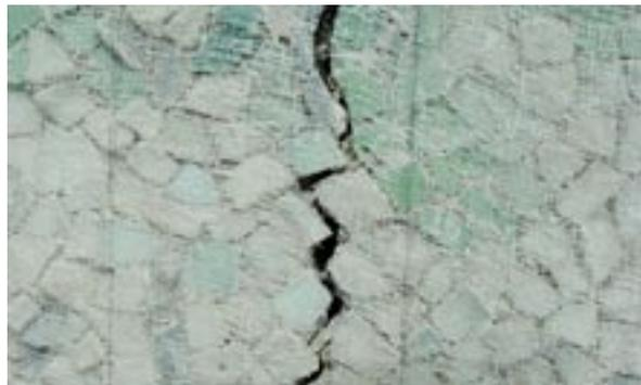
le sciage des joints verticaux, en provoquant leurs ruptures. La relative irrégularité d'un joint rompu présentait à nos yeux l'avantage de conserver intacte la totalité des tesselles dans leur position originale. Ainsi fut fait. Les plaques cintrées des angles de la mosaïque ont été déposées sans beaucoup plus de difficulté.
