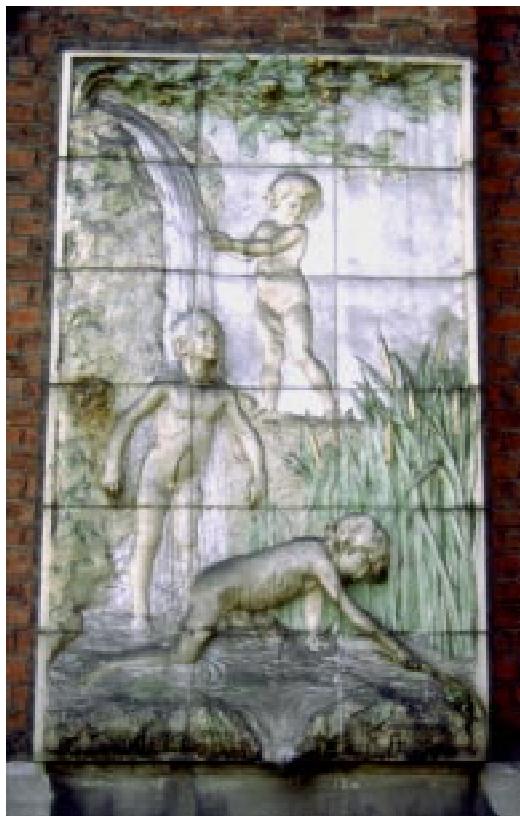
Fig.10 - Le bas-relief de Constant Roux était monté au mortier de ciment sur un mur extérieur de l'ancien musée de Roubaix.
